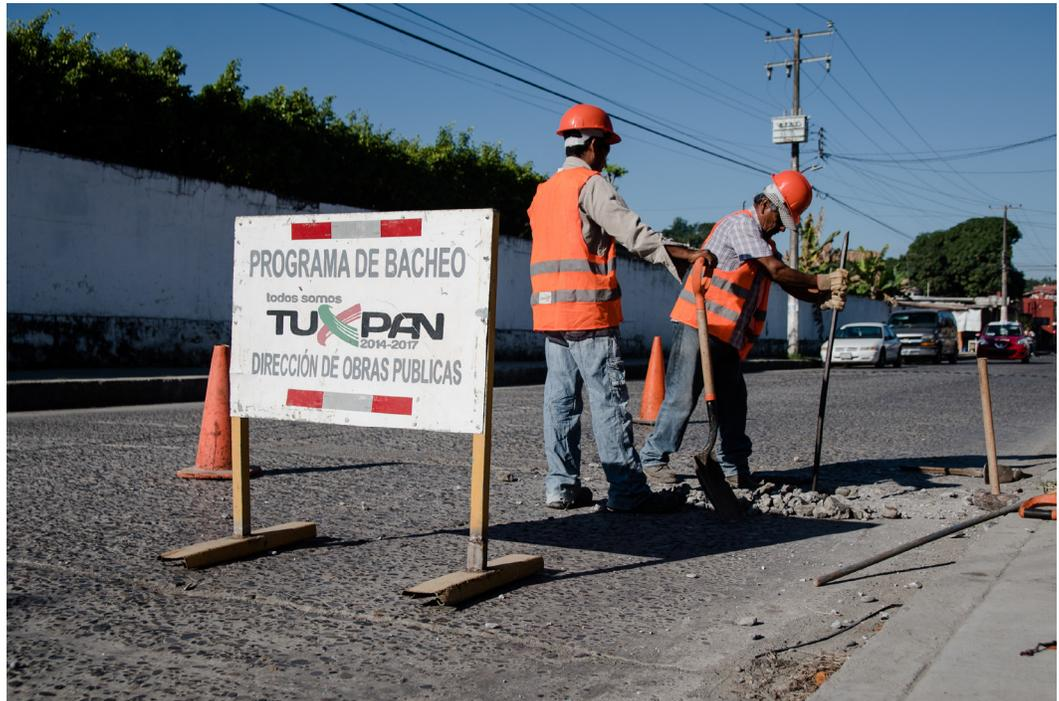
Por medio de este programa permanente se llevaron a cabo las reparaciones necesarias, en varias calles de la ciudad que se encontraban deterioradas por el uso de tráfico, por penetración de lluvia y por fugas en las líneas dañadas de agua y drenajes que provocan socavaciones, estas líneas que prestan servicio a los ciudadanos 124 acciones de bacheo en equivalentes a 372 M2.
