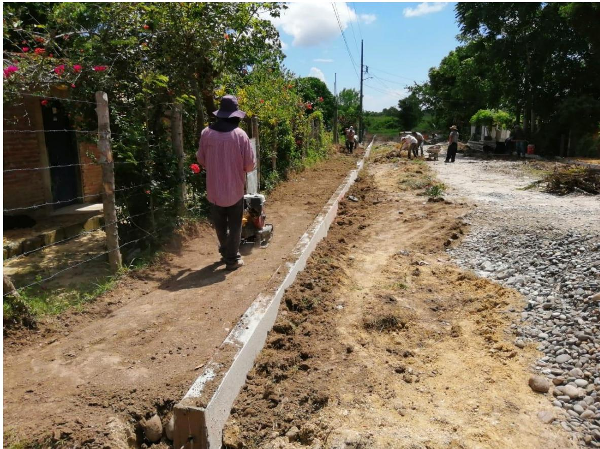
0034 RELLENO EN ZANJAS CON MATERIAL INERTE EN CAPAS DE 20 CMS. DE ESPESOR POR MEDIOS
