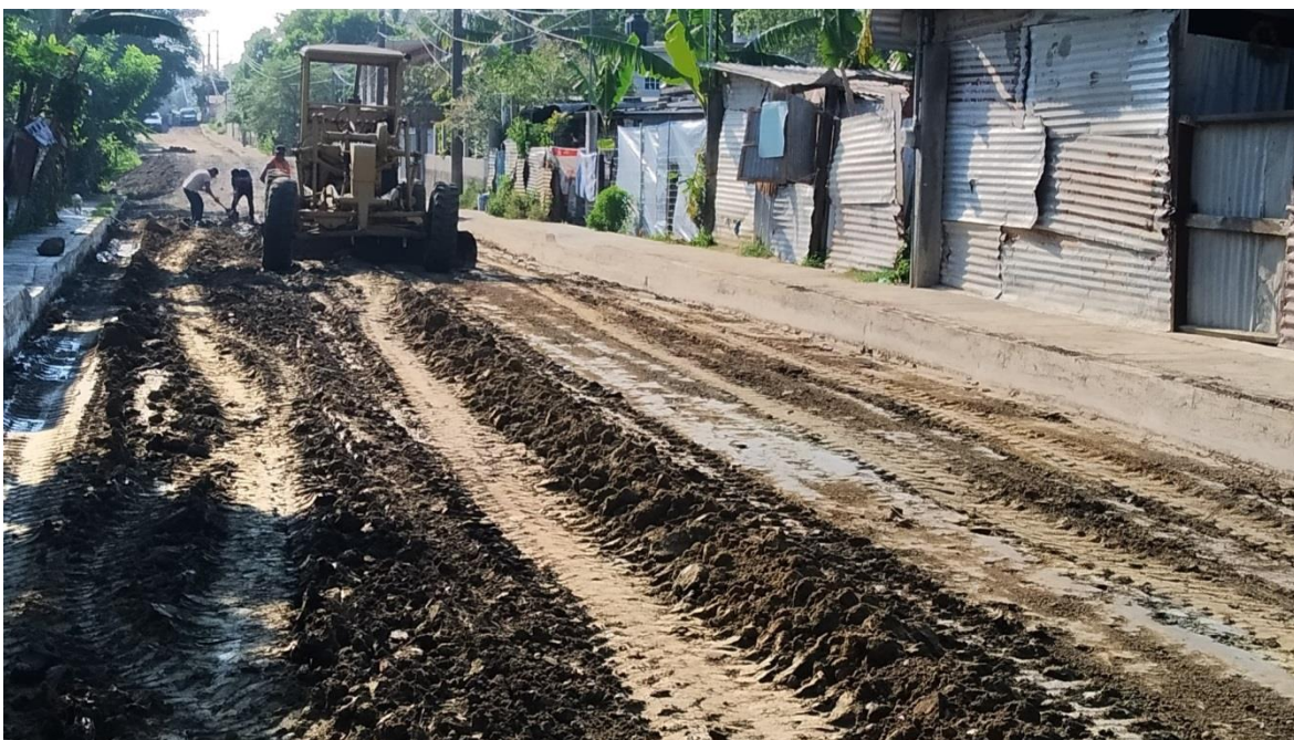
COTE CON MEDIOS MECANICOS EN MATERIAL TIPO II
