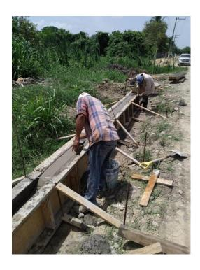
ELABORACIÓN DE GUARNICION DE SECCION TRAPEZOIDAL 15X20X50 CON CONCRETO F'C=150 KGCM2 ACABADO PULIDO.
