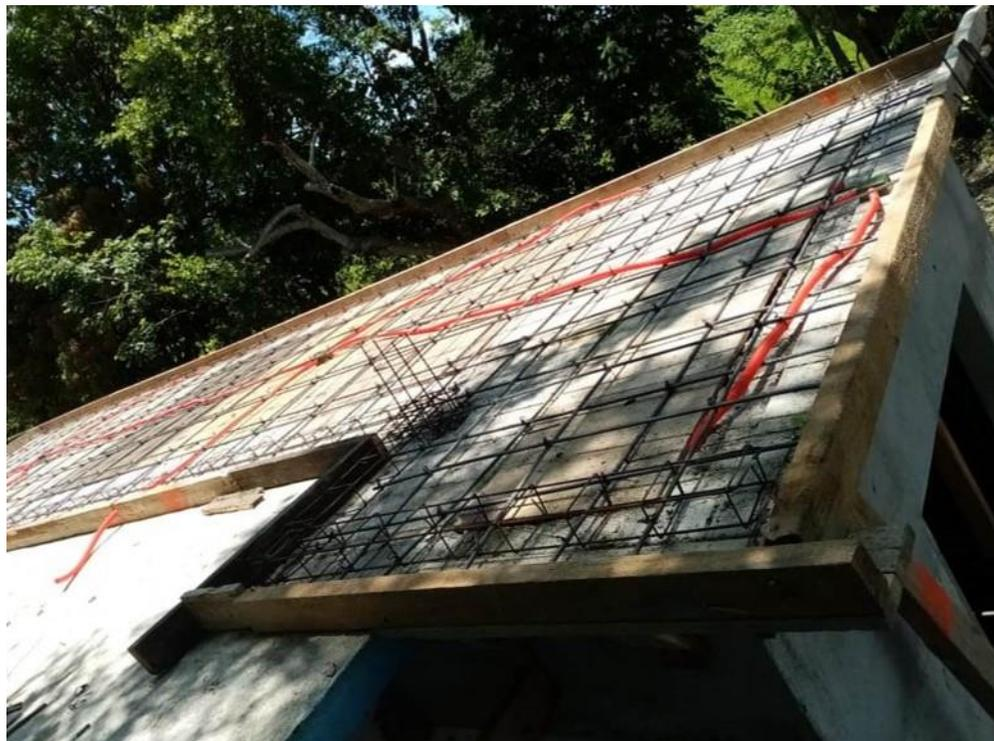
CADENA DE CERRAMIENTO AHOGADA EN LOSA DE 15 X 10 CMS DE CONCRETO FC= 150 KG-CM<sup>2</sup>, REFORZADA CON ARMEX 10X15-4 Y LOSA MACIZA DE 10 CMS DE ESPESOR DE CONCRETO FC= 200 KG-CM<sup>2</sup>, REFORZADA CON 6.945 KGS-M<sup>2</sup> DE VARILLAS DE 3-8.
