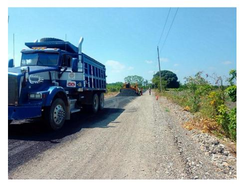
TENDIDO DE CARPETA APLICADA EN CALIENTE DE 5 CM DE ESPESOR POR MEDIOS MECÁNICOS (FINISHER)
