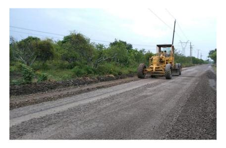
AFINE Y COMPACTACION DE SUBRASANTE Y TENDIDO DE BASE HIDRAULICA CON MATERIAL DE BANCO TRITURADO DE 20 CMS DE ESPESOR.
